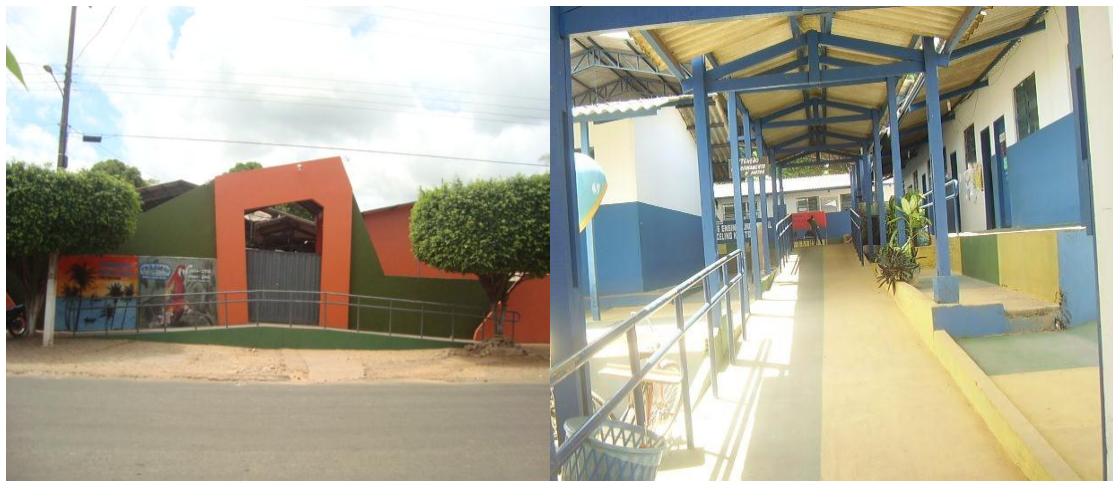
Figura 03 –Partes externa e interna da EEEFM Juscelino Kubitscheck.
